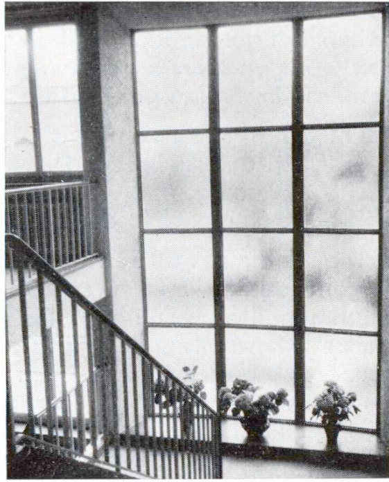
Abb. 4. Das grosse Fenster mit Befonspossen im Treppenhaus.
