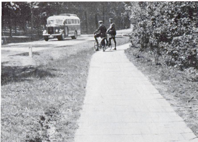
Abb 1. Holländischer Radfahrweg aus kleinen Cementplatten.
