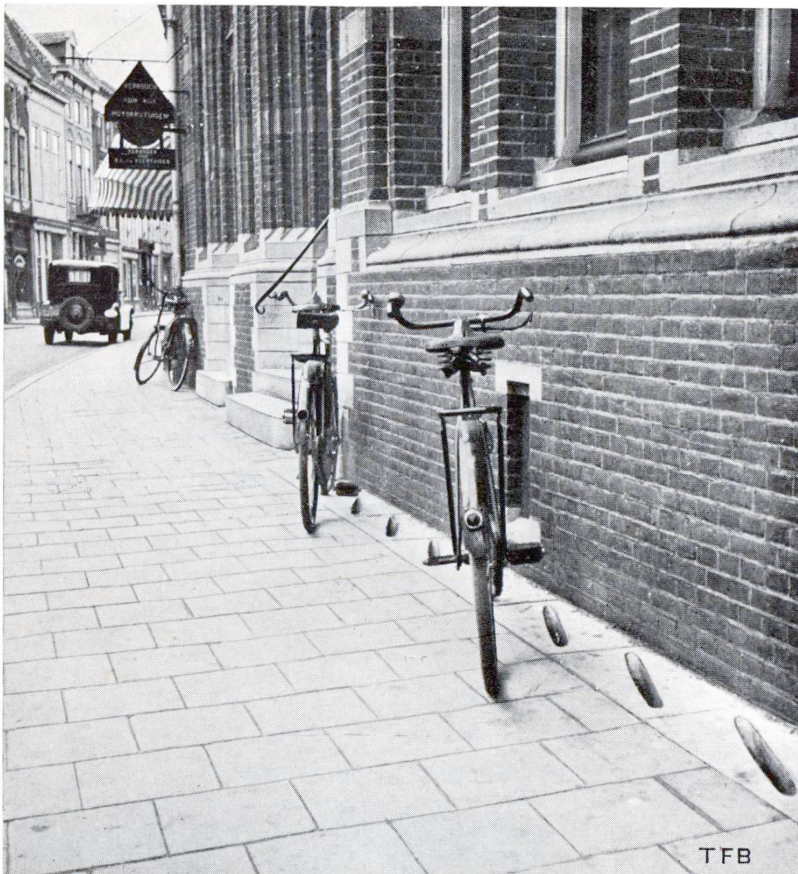
Abb. 7. Beton-Formsteine zur Fahrradgaragierung.
