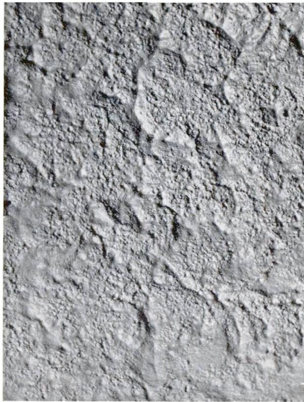
Dieser Anspritz dient erstens zur Gewährleistung einer guten Haftung zwischen Mauerwerk und eigentlichem Verputz und zweitens zur Abdichtung. Infolgedessen muss er lückenlos angetragen werden, eventuell in zwei dünnen Schichten. Er soll rau und griffig sein.
