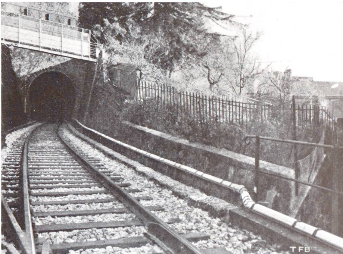
Fig. 3 Eternit-Zorès als Kabelschutz längs eines Bahngelaises. Eternit wird von vagabundierenden Strömen nicht angegriffen.
