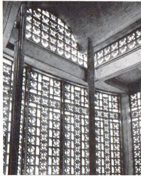
**Neue Universität in Freiburg.** Inneres der Kapelle in sichtbarem Eisenbeton ausgeführt. F. Dumas u. D. Honegger, Arch. in Freiburg; Jean Barras, Ing.
