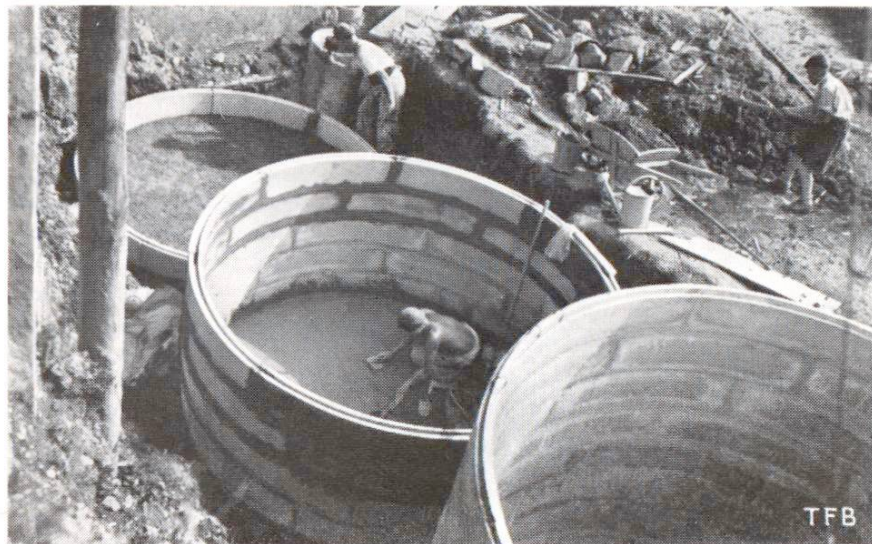
Fig. 4 Silobatterie im Bau Silobau Luzern, Werchlaube
