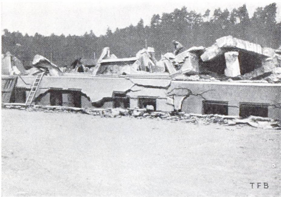
Abb. 5 Abbruch eines Fabrikgebäudes durch Sprengung. (nach E. Stettler, s. Lit.).
