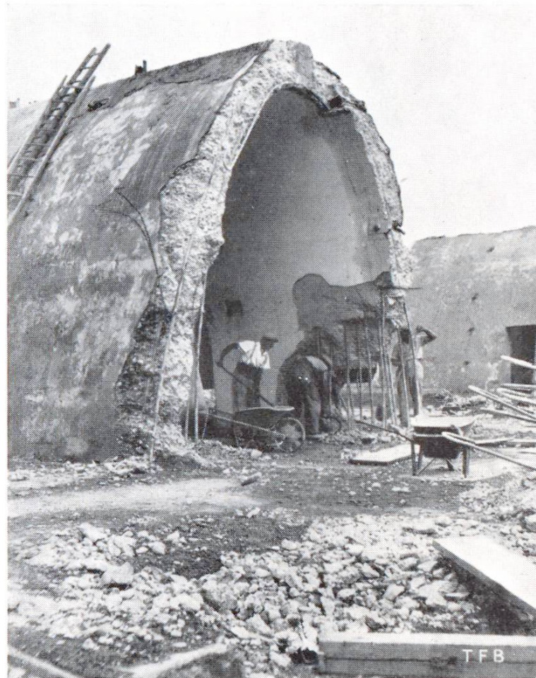
Abb. 4 Abbruch eines armierten Betongewölbes mittelst Abbauhämmern.
