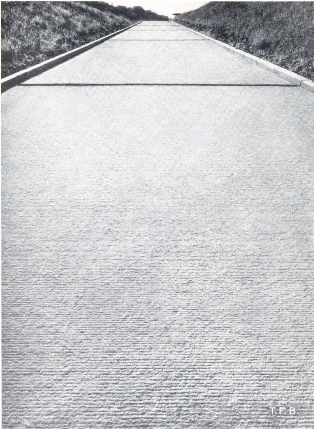
Abb. 3 Oberfläche mit feiner Rippelung für geringe Steigungen
