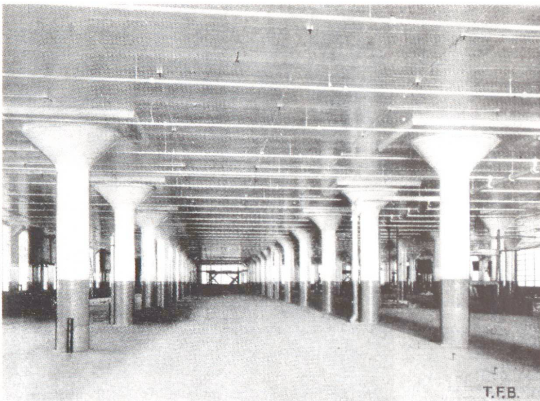
Abb. 5 Pilzdecke in grossem Warenhaus (U.S.A.)
