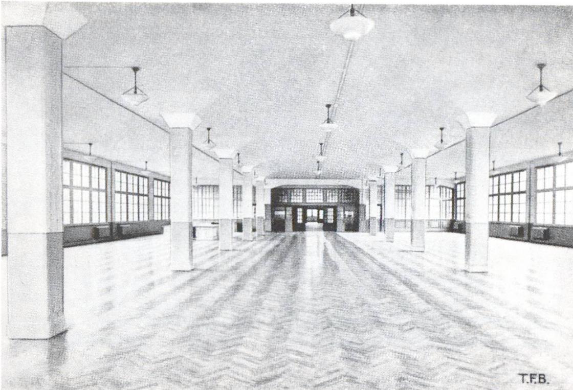
Abb. 6 Pilzdecke (1926) in einer Maschinenfabrik
