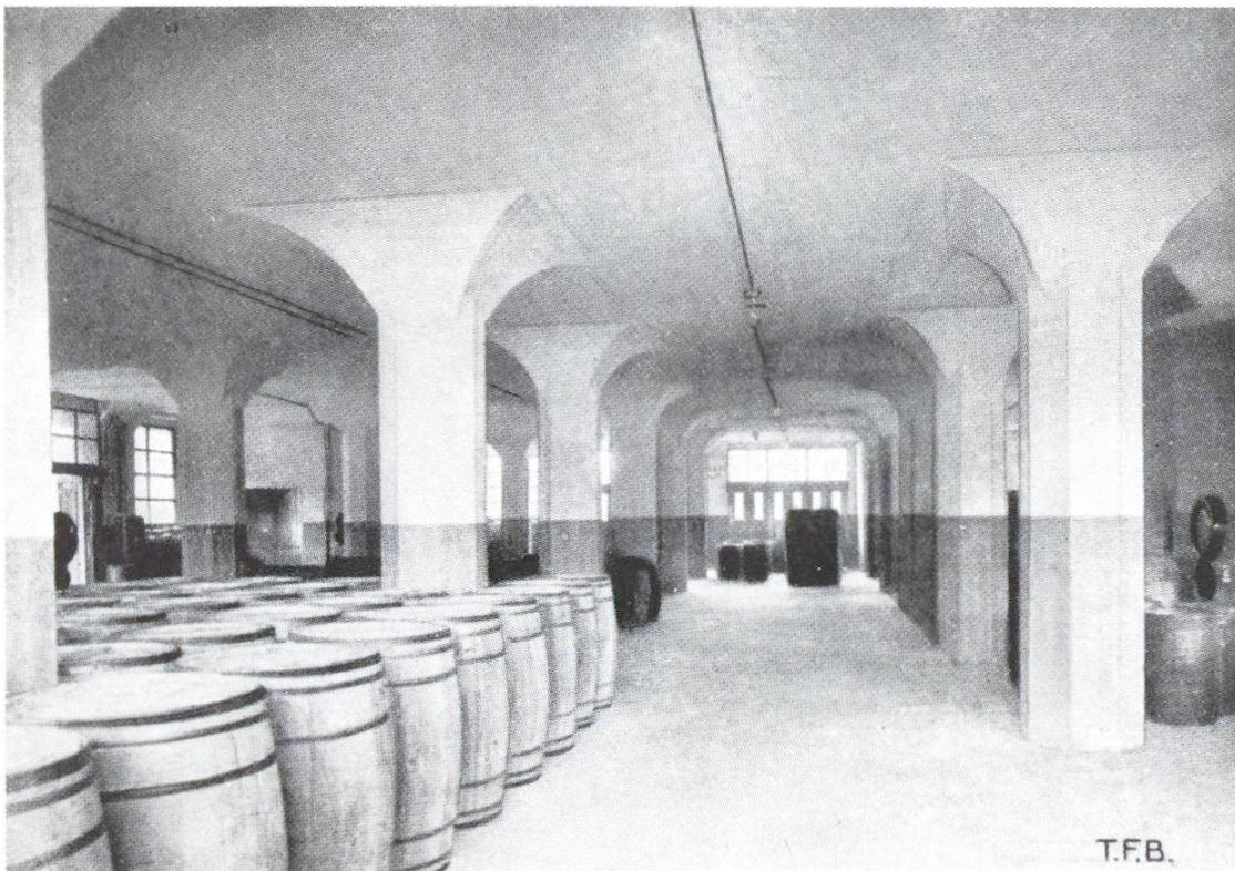
Abb. 7 Pilzdecke in Lagerhaus einer chemischen Fabrik
