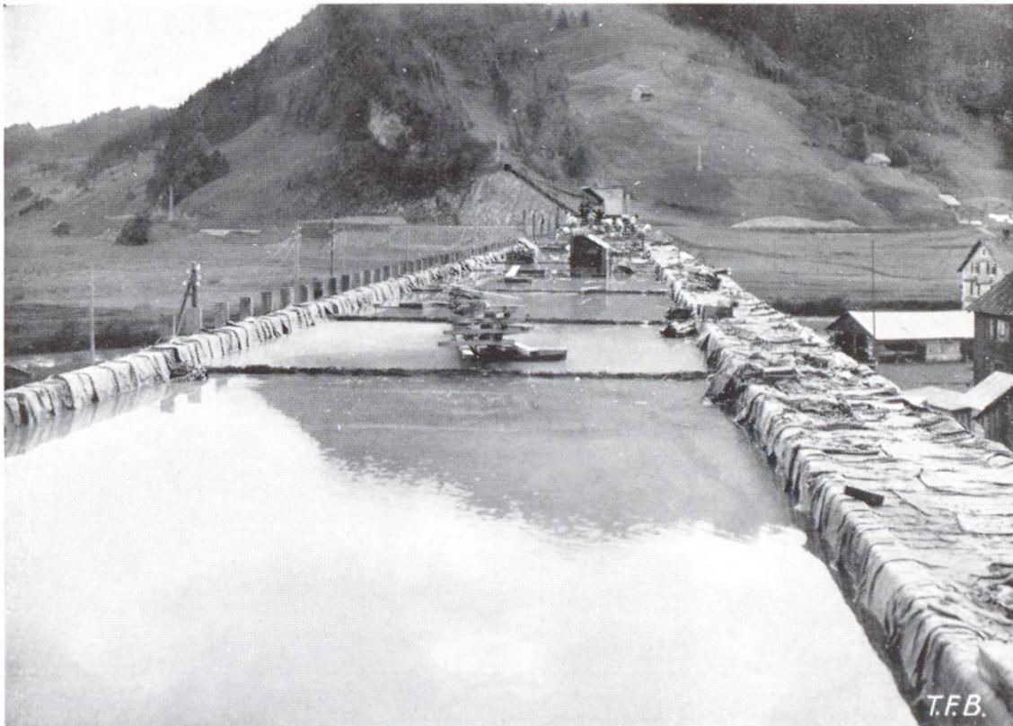
Abb. 2 Feuchthaltung einer Eisenbetonfahrbahn. Überschwemmen der versenkten Fahrbahn. Bedeckung der überhöhten Flächen mit feuchten Säcken.
