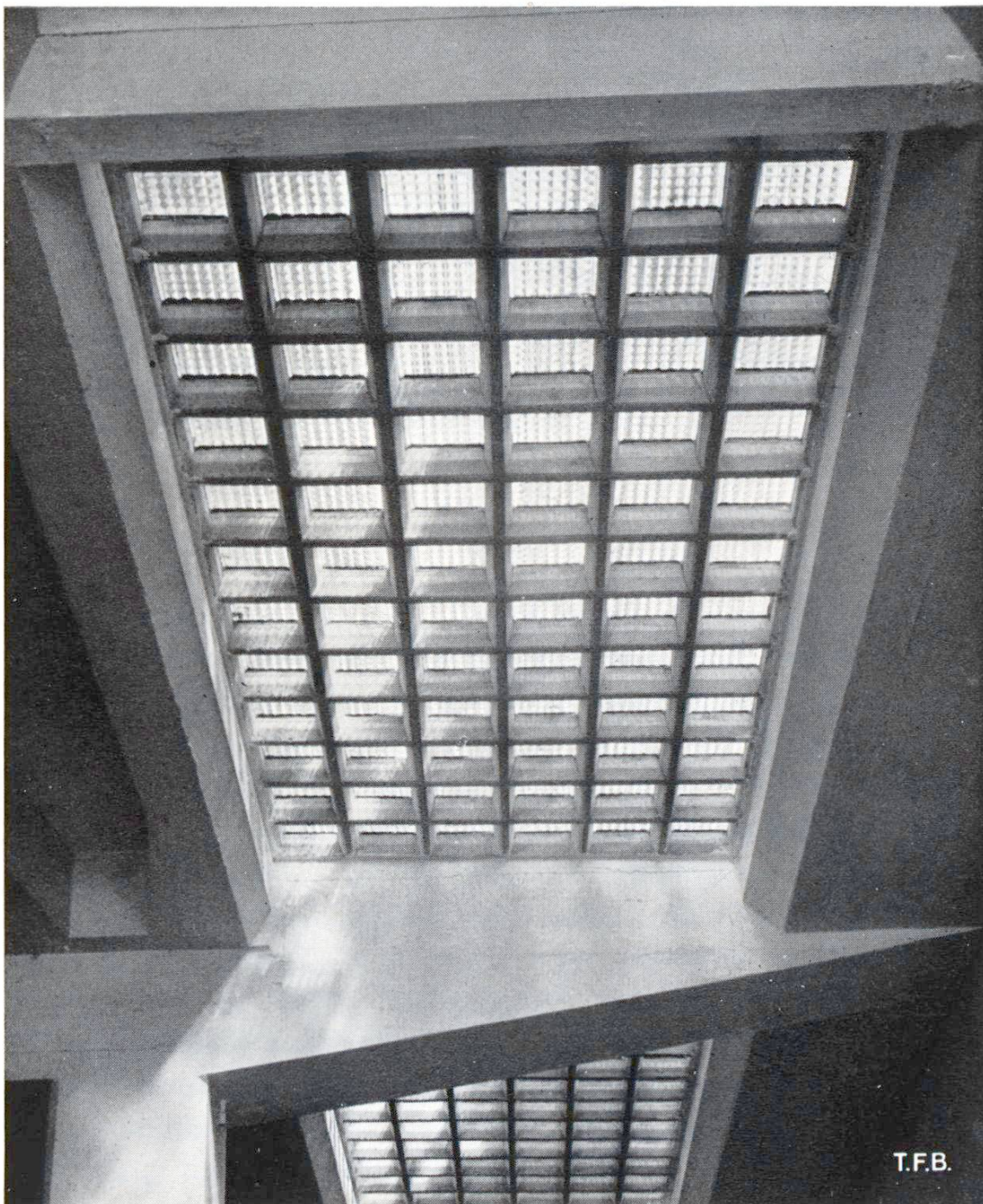
Abb. 7 Begehbares Oberlicht aus Glasbeton. Glasfliesen auf Betonsprossen
