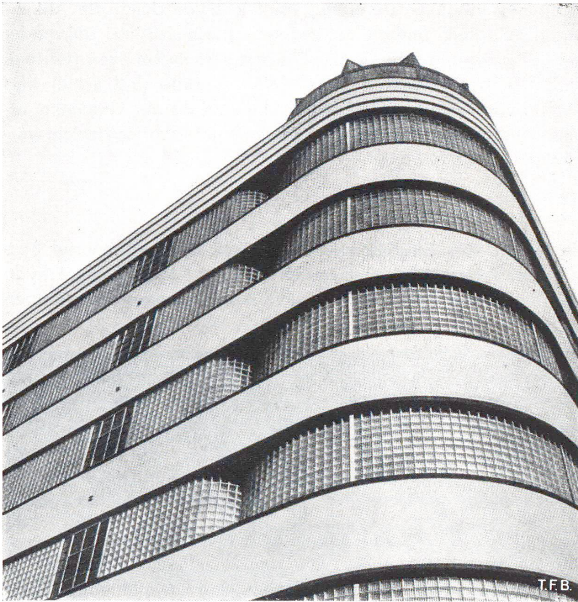
Abb. 4 Fassadengestaltung mit Glasbeton
