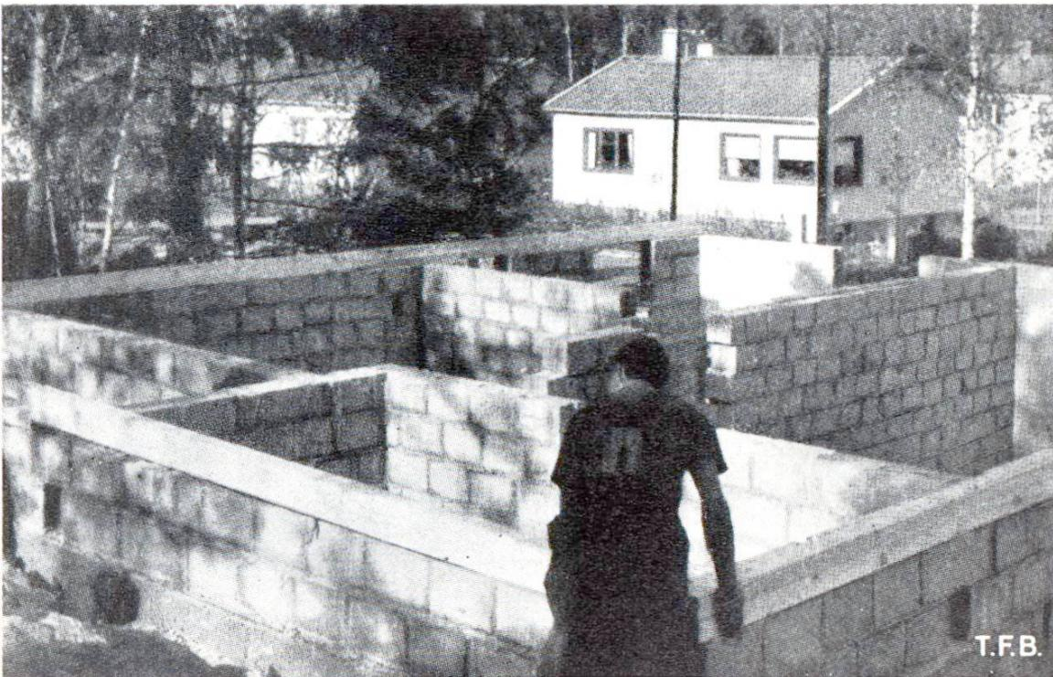
Abb. 11 Bau mit Betonhohlblöcken in einer Siedlung
