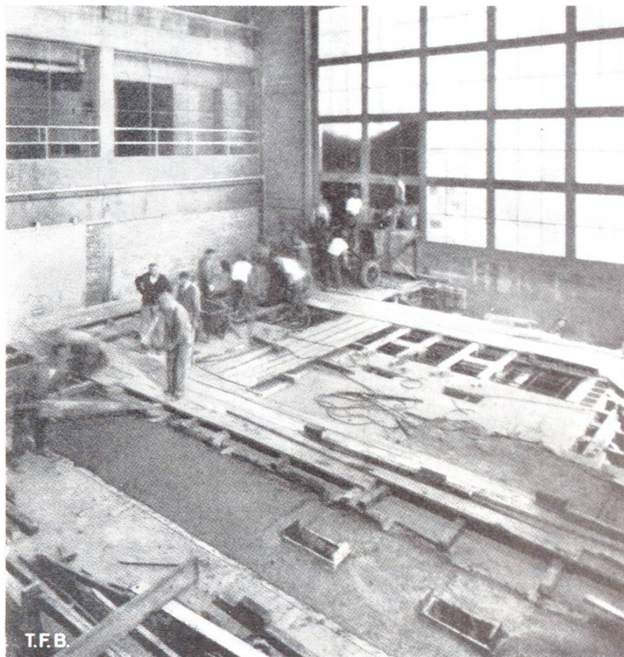
Abb. 5 Giessen eines Balkens zwischen zwei fertigen Balken. Die Aussparungen in der Kopffläche sind Greiflöcher, in denen die durchgehenden Ankerbolzen sichtbar sind
