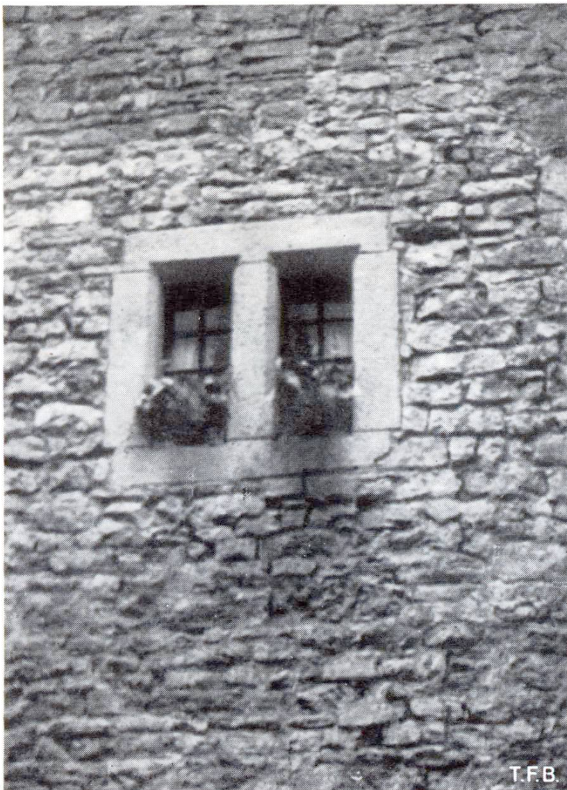
Abb. 5 Mauerwerk aus dem späten Mittelalter. Habsburg
