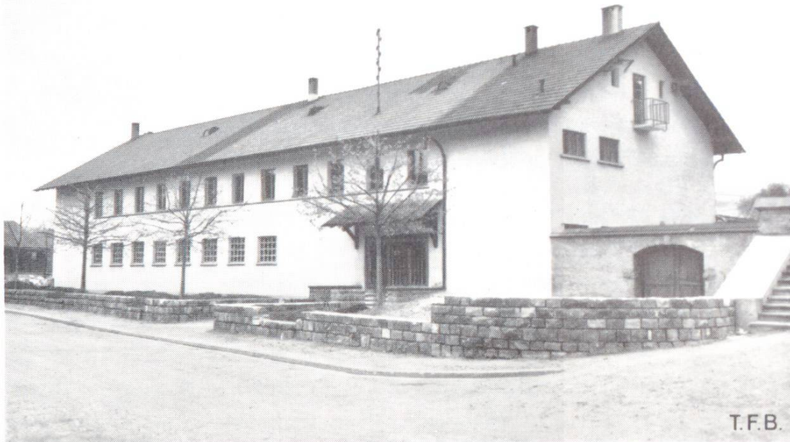
Abb. 2 Lehrhalle Sursee des Schweizerischen Baumeisterverbandes
