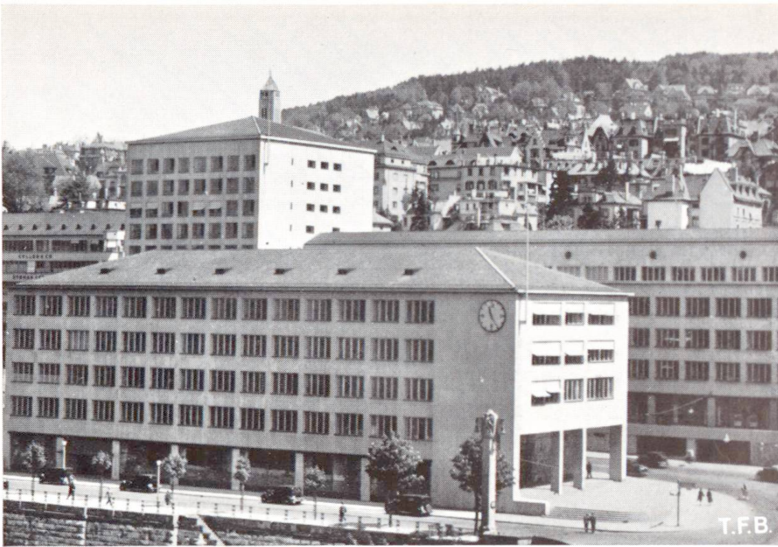
Abb. 3 Verwaltungsgebäude. Säulen in Verbundbauweise mit HPC ermöglichten einen raschen Baufortschritt (Photoglob Zürich)
