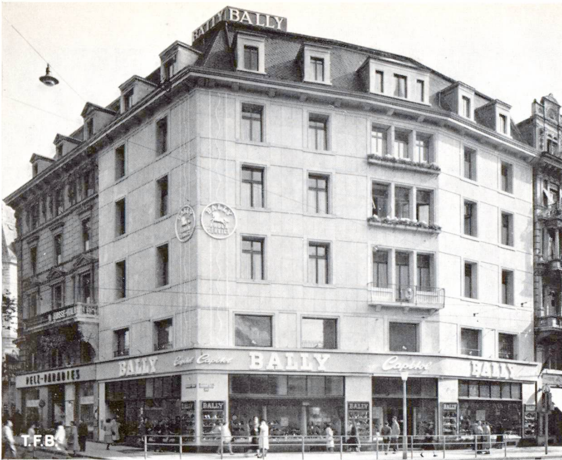
Abb. 2 Mit Natursteinplatten umgestaltete Fassade. Man beachte die etwas vorspringenden, waagrechten Bindersteine. Links ein älteres Gebäude in Mischmauerwerk
