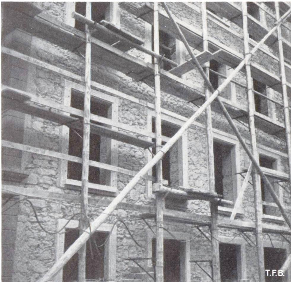
Abb. 6 Renovation — unter dem Verputz tritt ein festes, altes Bruchsteinmauerwerk hervor.
