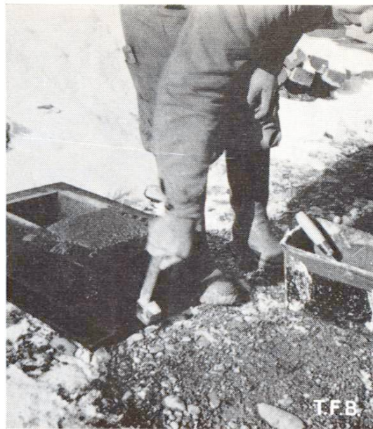
Abb. 6 Zusätzliche Verdichtung durch leichtes Abklopfen der Form
