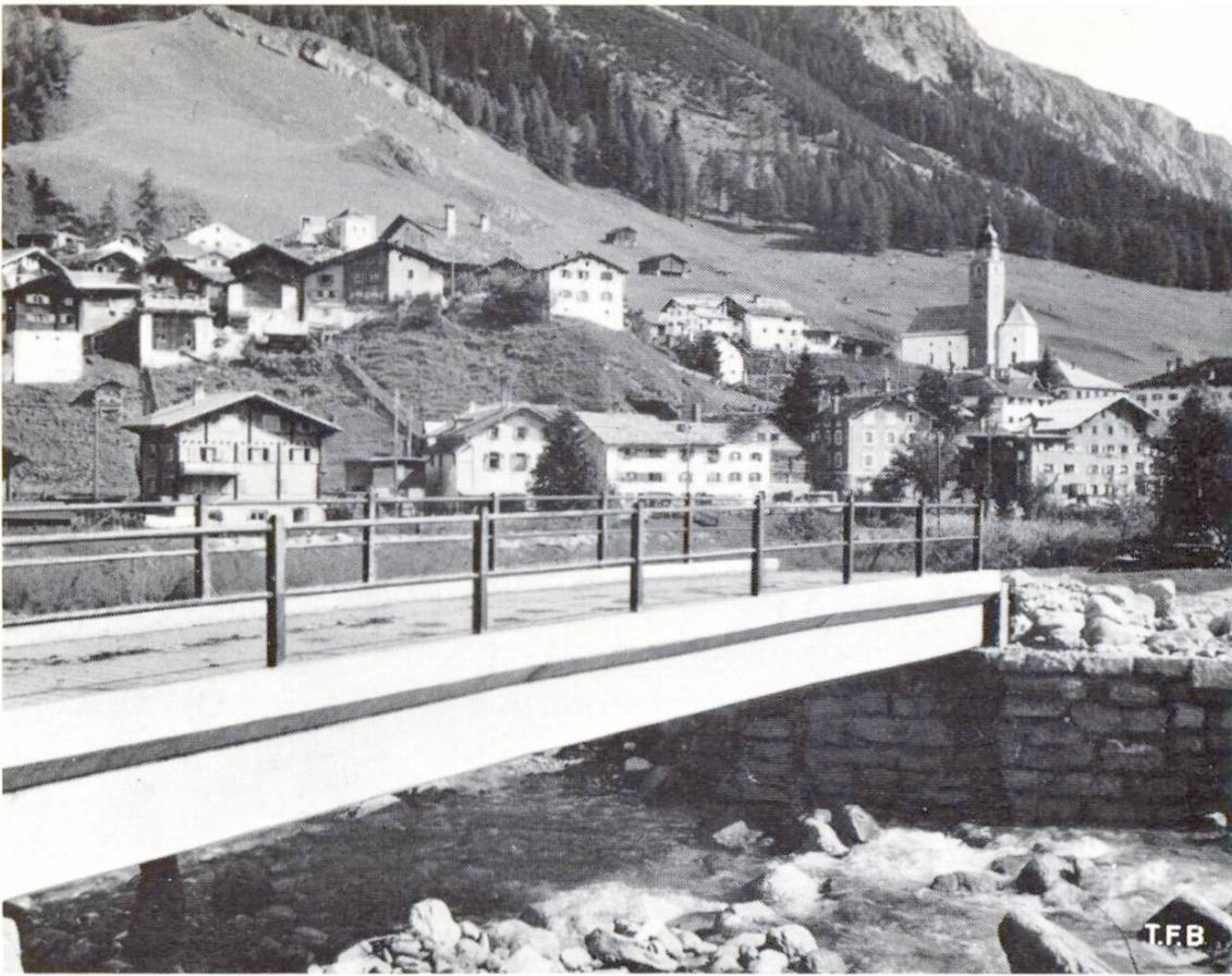
Abb. 3 Kleine Brücke aus vorfabrizierten Betonbalken. Spannweite 13 m
