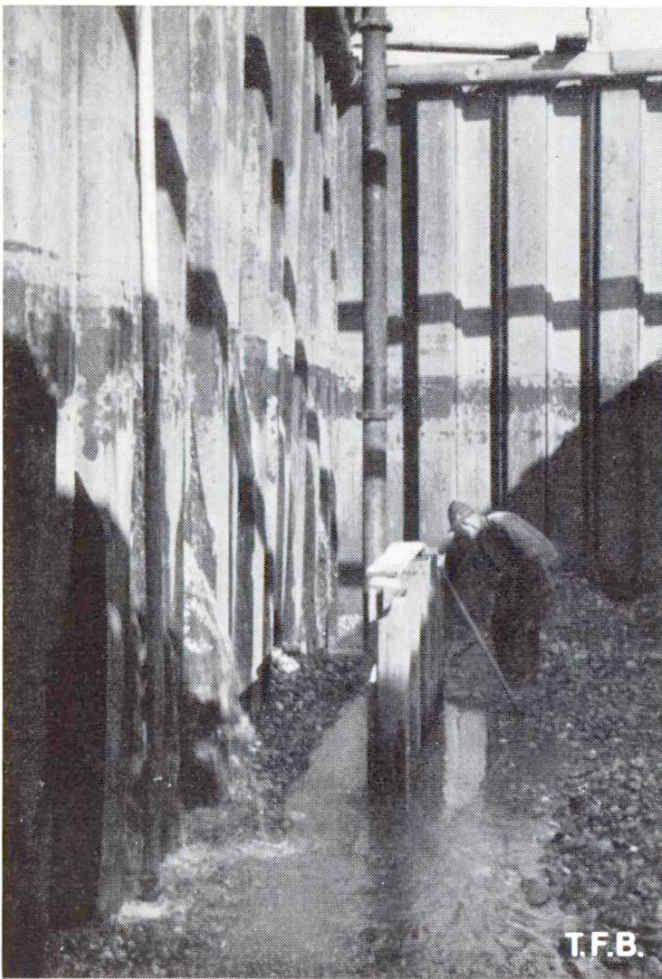
Abb. 4 Blick in die Baugrube eines Strompfeilers
