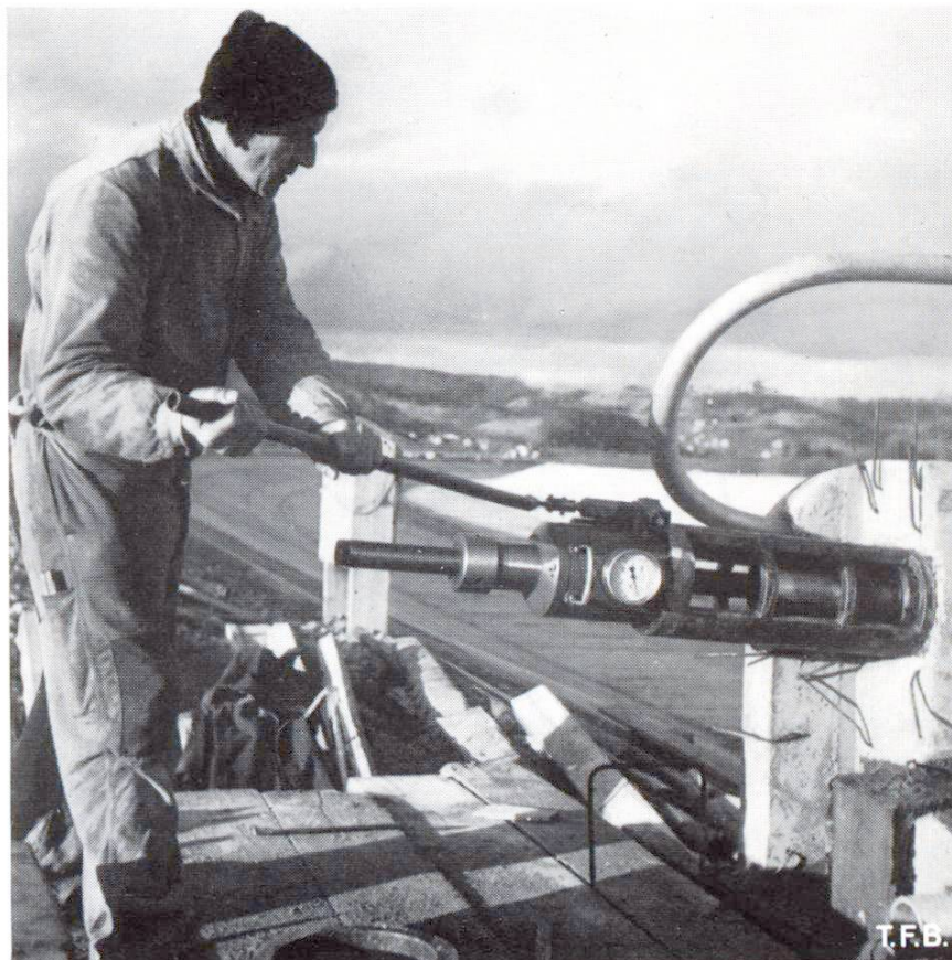
Abb. 13 Hydraulische Spannpressen in Aktion. Durch die kleine Pumpe an der oberen Seite wird Öl in den Druckraum gepresst. Das Manometer zeigt bereits ca. 100 at an, was einer Zugkraft von 5–10 t entspricht.
