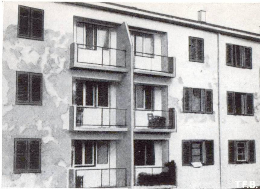
Abb. 3 Ablösung einer Putzschicht infolge schlecht gereinigter Unterlage
