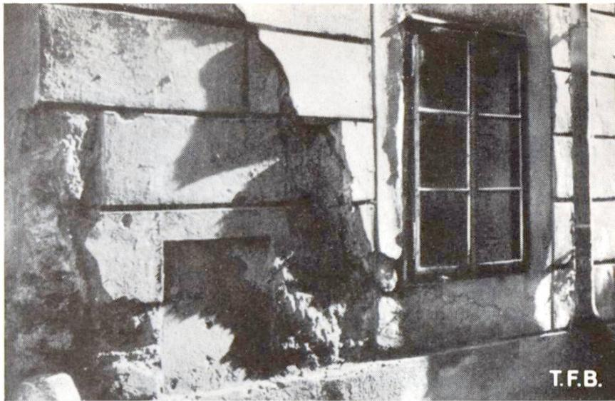
Abb. 5 Ablösung eines Mörtelüberzuges, der an einer zu glatten Fläche und zudem in zu grosser Dicke aufgetragen wurde. Die Dicke einzelner Putzschichten soll 2 cm nicht übersteigen
