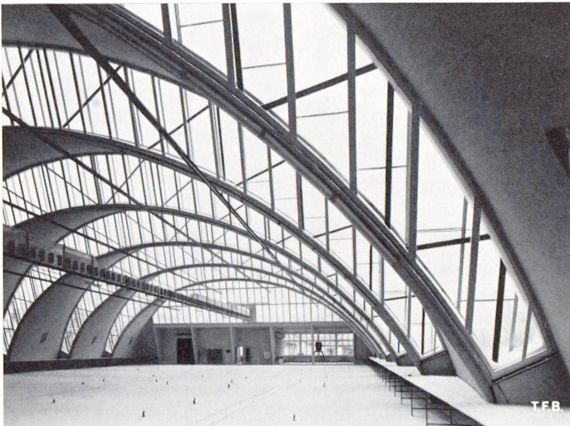
Abb. 6 Blick ins Innere der Zylindershedhalle gegen Norden. Die einzelnen Bogen folgen sich in Intervallen von 7 m und haben eine Spannweite von 28,6 m
