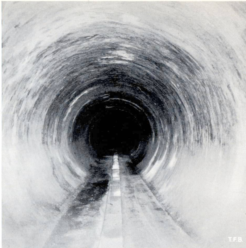
Abb. 6 Profilgerechte Spritzbetonverkleidung in einem Druckstollen der Maggia-Kraftwerke (Aufnahme MKW)
