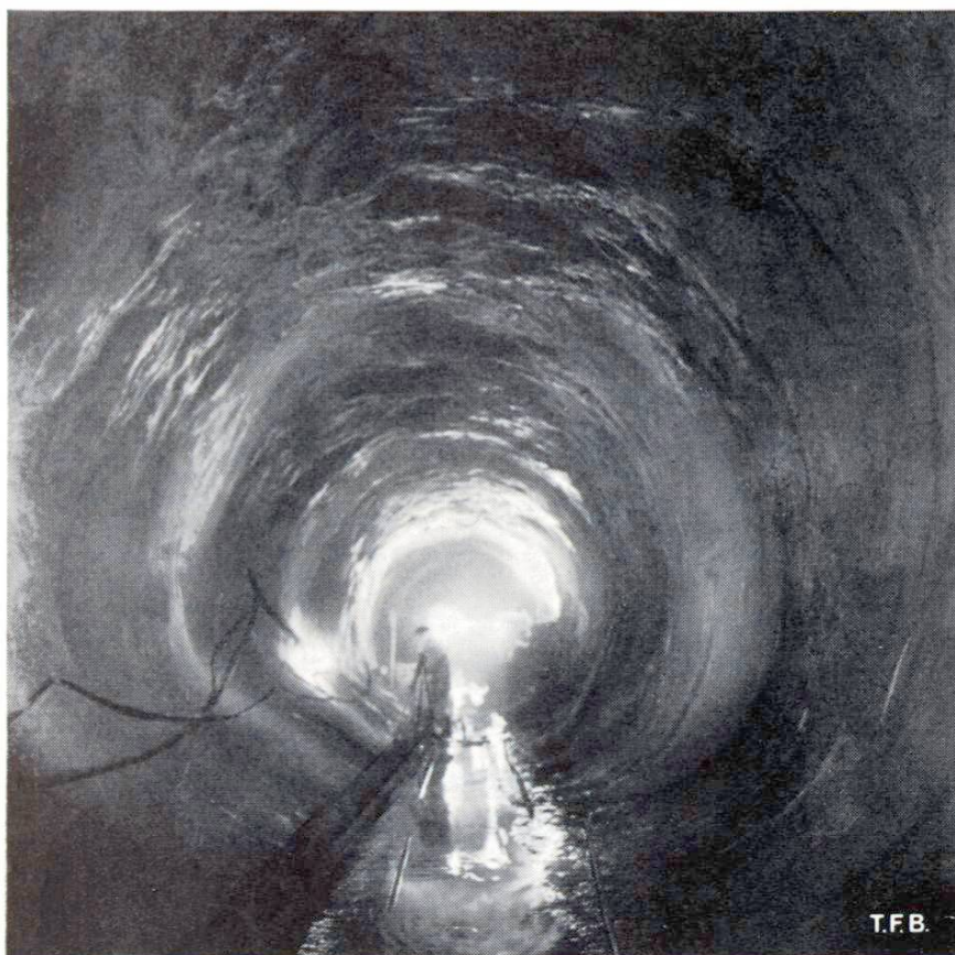
Abb. 5 Abgehellte Spritzbetonverkleidung im Druckstollen Grande Dixence - Fionnay. Länge 3,3 km, Innendruck bis zu 22 Atü.
