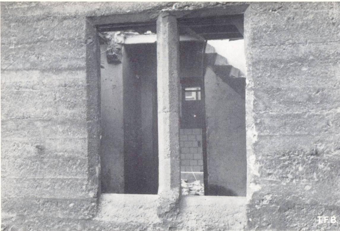
Abb. 2 Fassade mit Doppelfenster in Sichtbeton. Im Hintergrund die in Beton vorgefertigten Treppenstufen
