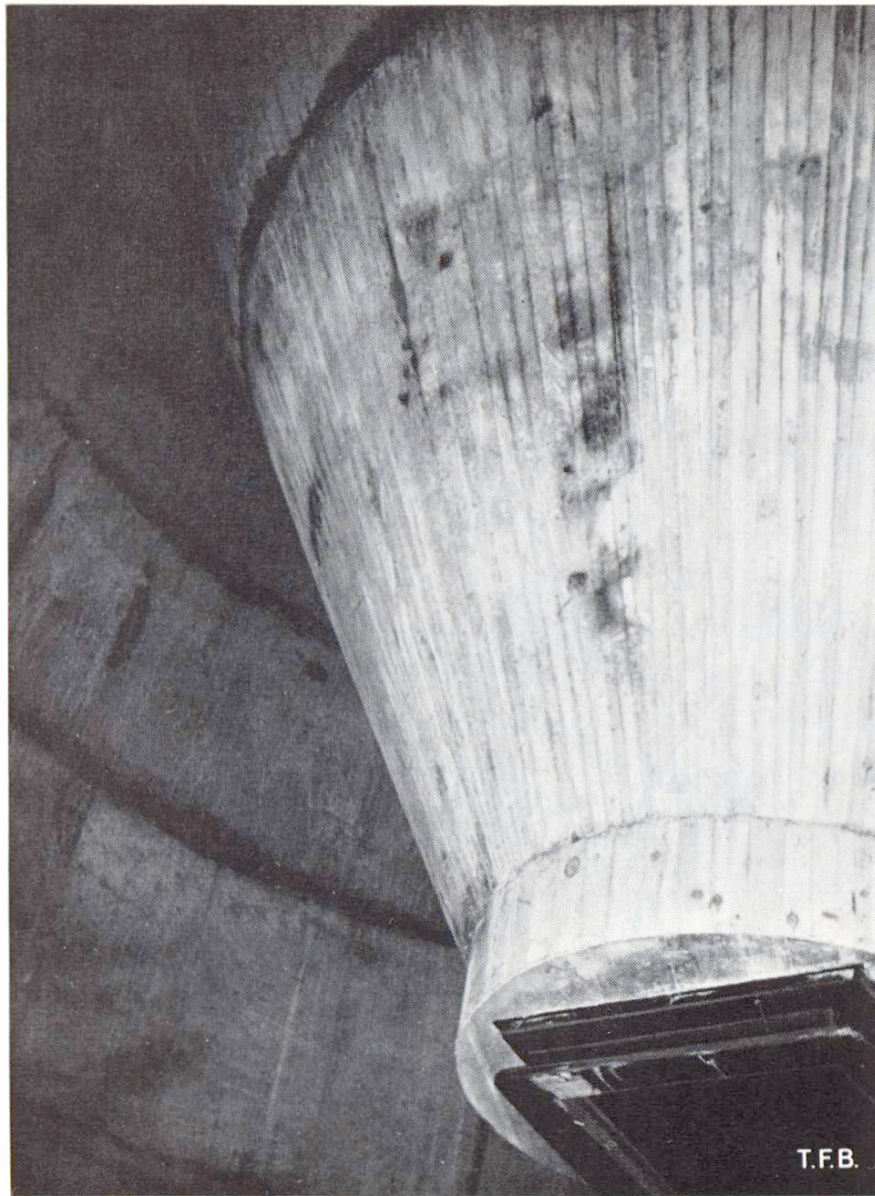
Abb. 5 Aschentrichter und Schieber des Kamins «Jura»
