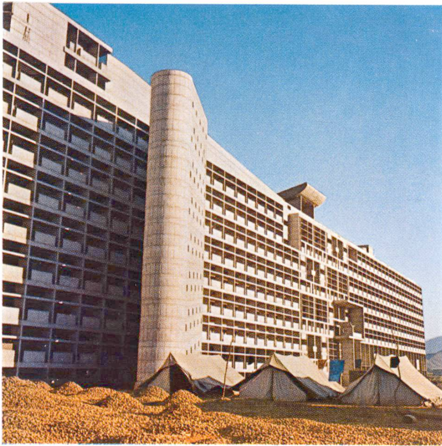
Abb. 4 Das Sekretariat; im Turm vor der Fassade ist eine bequeme Rampe, welche die Stockwerke untereinander verbindet
