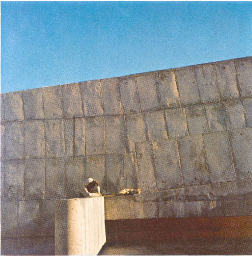
Abb. 8 Das Sekretariatsgebäude; ein Beispiel des rohen Betons ausgeführt in Blechschalung
