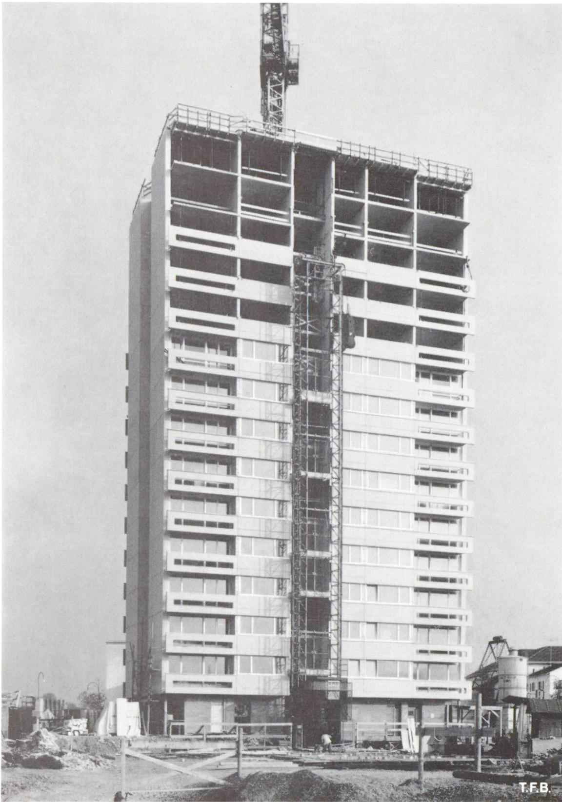
Abb. 3 Wohn-Hochhaus in Zürich, erstellt 1963 in der Allbeton-Bauweise durch die Firma H. Hatt-Haller. Die Fassadenplatten und Balkonbrüstungen sind vofabriziert.
