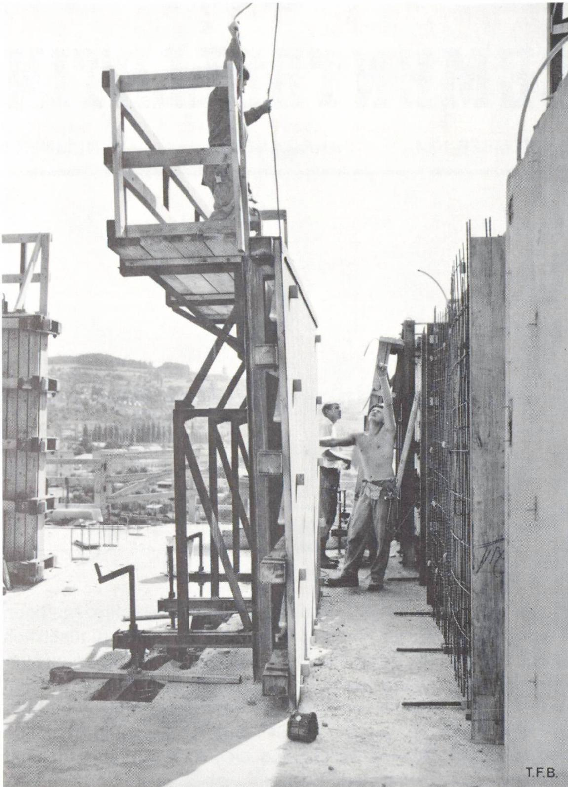
Abb. 1 Wandschalungselement, versehen mit einer Brücke für die Betonierarbeiten. Man erkennt das stählerne Trägergerüst und die Spindeln, die der genauen Aufstellung dienen. Das ganze Element ist soeben mit dem Kran abgesetzt worden. Links erkennt man den stirnseitigen Verbund von Schalung und Konterschalung mittels Stahlklammern und Keilen.
