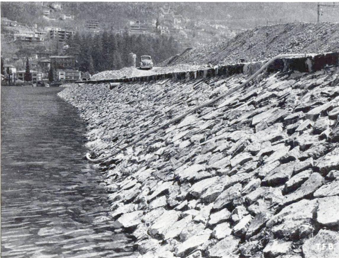
Abb. 6 Die Uferverkleidung aus versetzten Bruchsteinen, die nicht bis zur Oberfläche verfügt sind, fügt sich gut in das Landschaftsbild ein.
