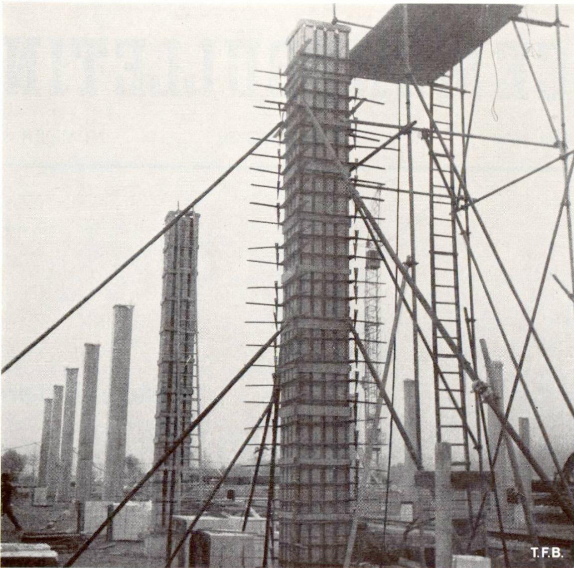
Abb. 1 Schalung für 6 m hohe Säule, bereit zum Betonieren. Schalungsdruck am Fusse 10 bis 15 t/m<sup>2</sup>.
