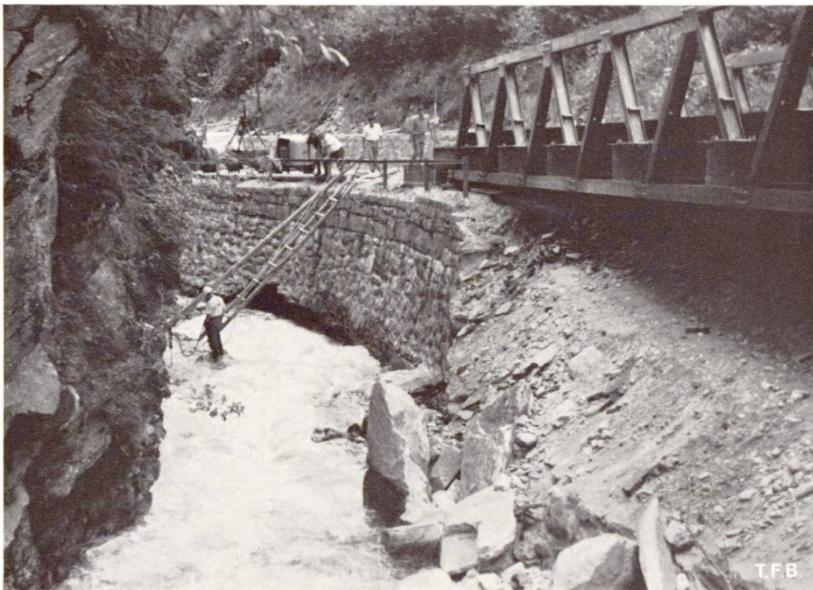
Abb. 3 Unterspülte Stützmauer.
