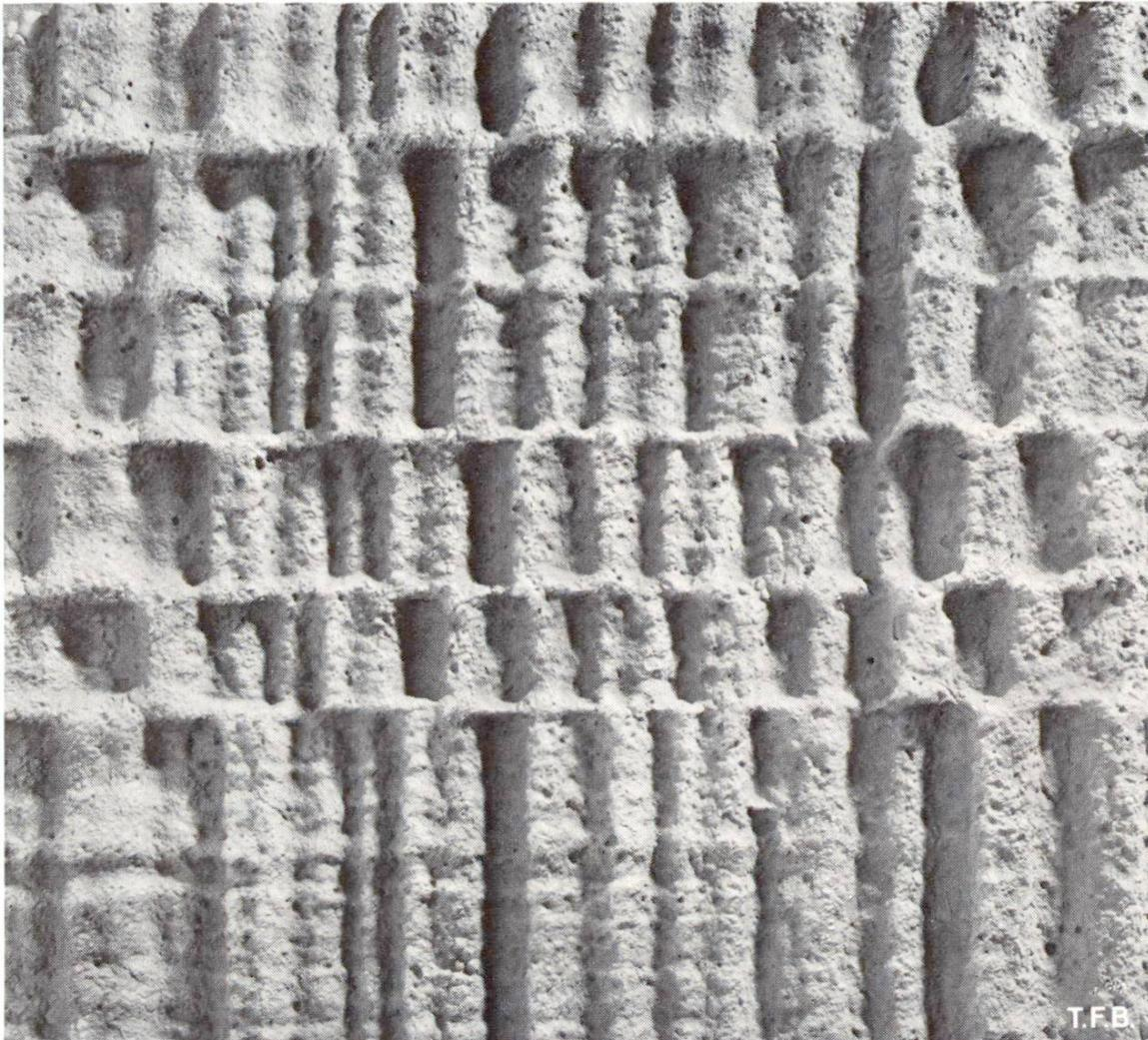
7 handlung und Reinigung der Bretter erübrigen. Die Schaumstofftafel, die beim Ausschalen zunächst am Beton haften bleibt, dient dann auch als Schutz gegen Frost, Beschädigung und Verschmutzung während der Rohbauperiode.
