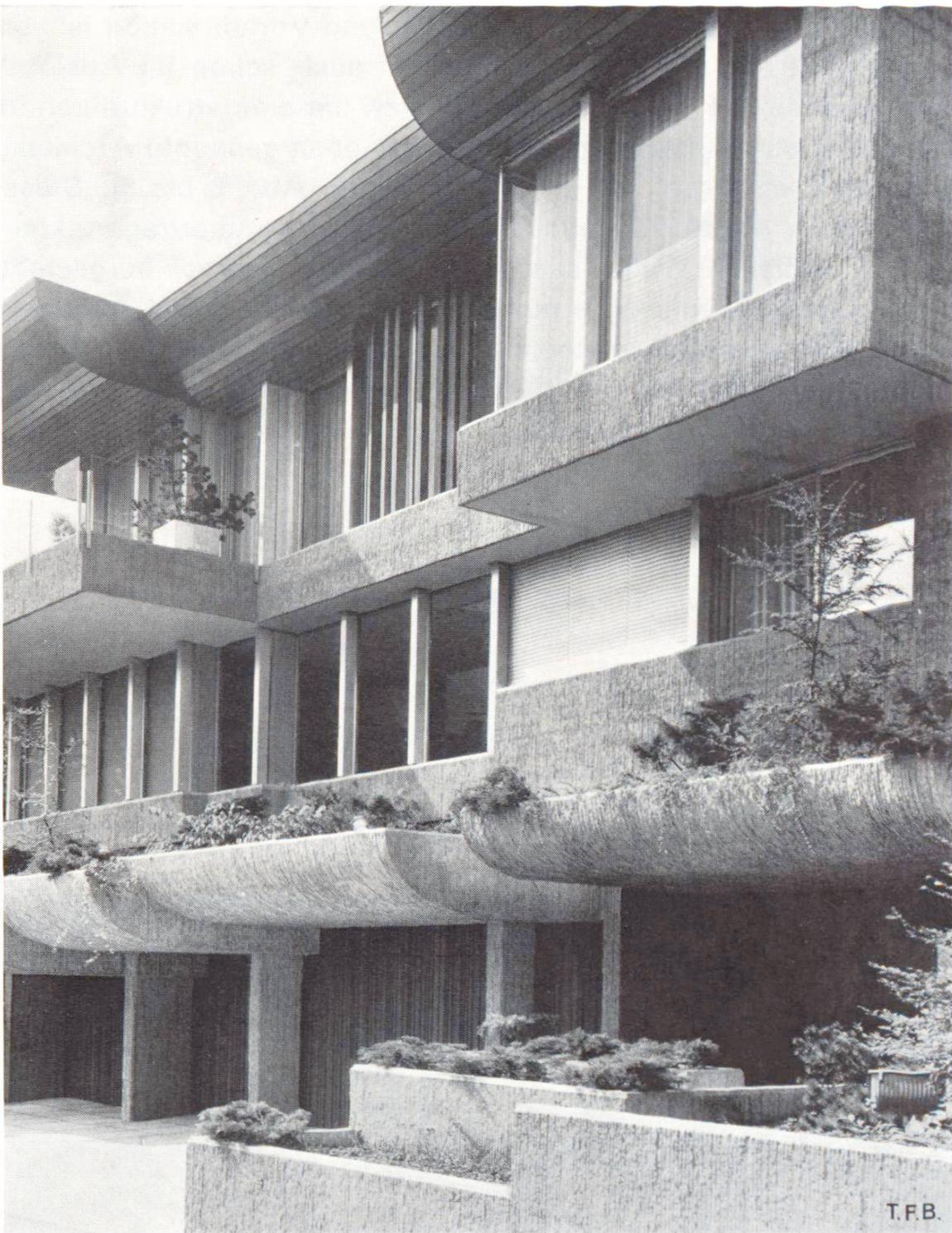
Abb. 5 Strukturierung des Sichtbetons mittelst Haselruten, die inwendig der Schalung dicht angenagelt worden sind. Einfamilienhaus in Kilchberg ZH. Architekt: R. Mathys, Zürich.
