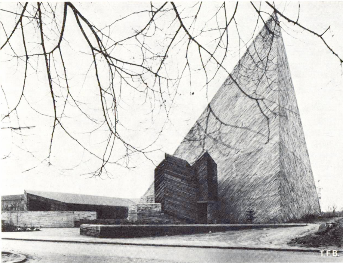
Abb. 2 Weiterentwicklung der rohen Bretterschalung zum strukturierten Sichtbeton. Zentrum der evangelischen Gemeinde Buchforst/Keulen BRD. Architekten: Rasch und Wolsky, Sinnerdorf.
