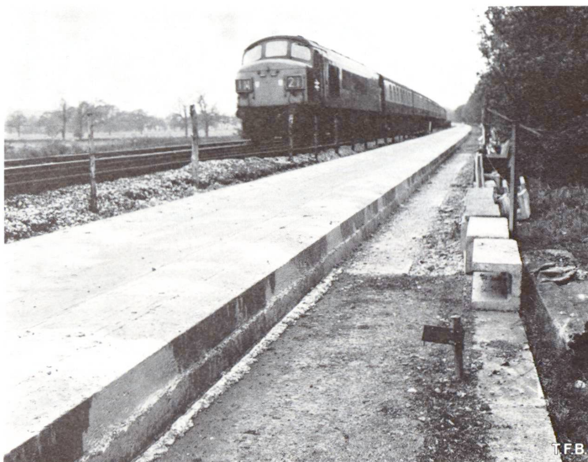
Abb. 4 Betonband für Geleisebau im Rohbau fertiggestellt. Es handelt sich um die Versuchsstrecke für den ordentlichen schweren und z.T. extrem schnellen Zugverkehr.
