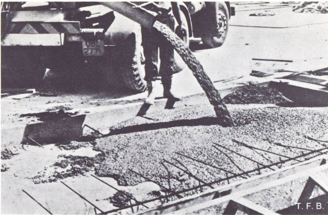
Abb.2 Selbständige Ausbreitung des Fließbetons ohne Entmischungserscheinungen (Bild aus CCA-Report, s. Literaturangabe).
