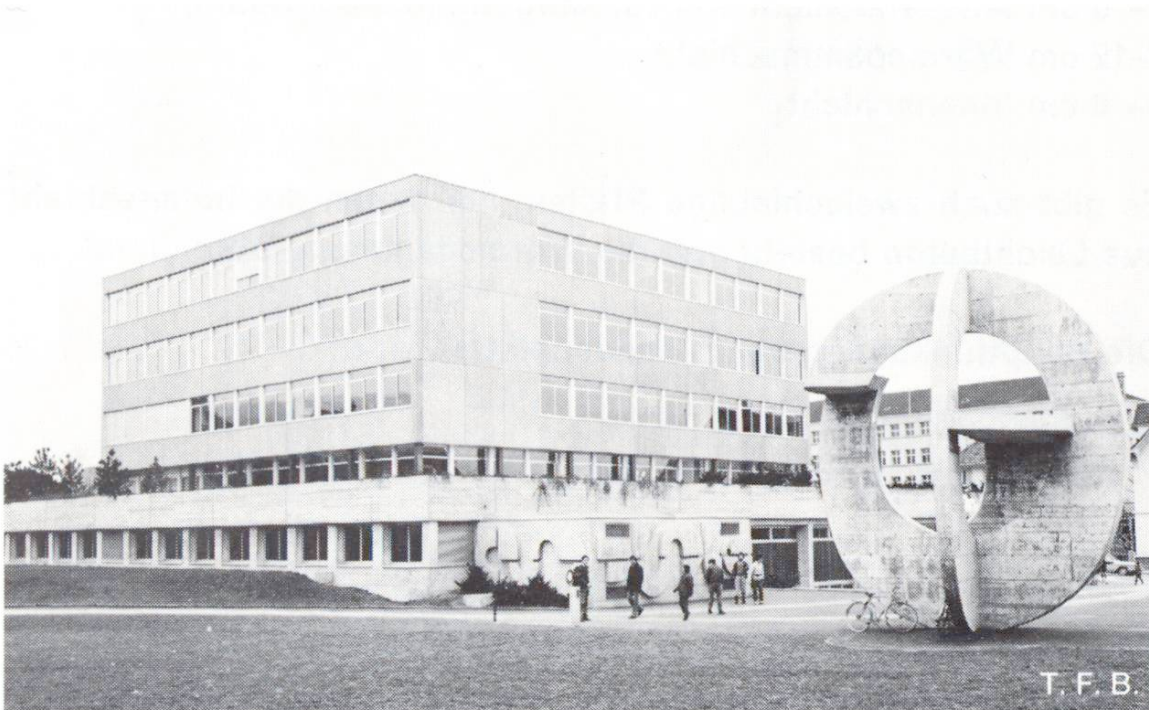
Abb. 1 Gewerbeschulhaus im Limmattal mit klassischem Sichtbeton und Fassadenplatten mit Rippenstruktur.
