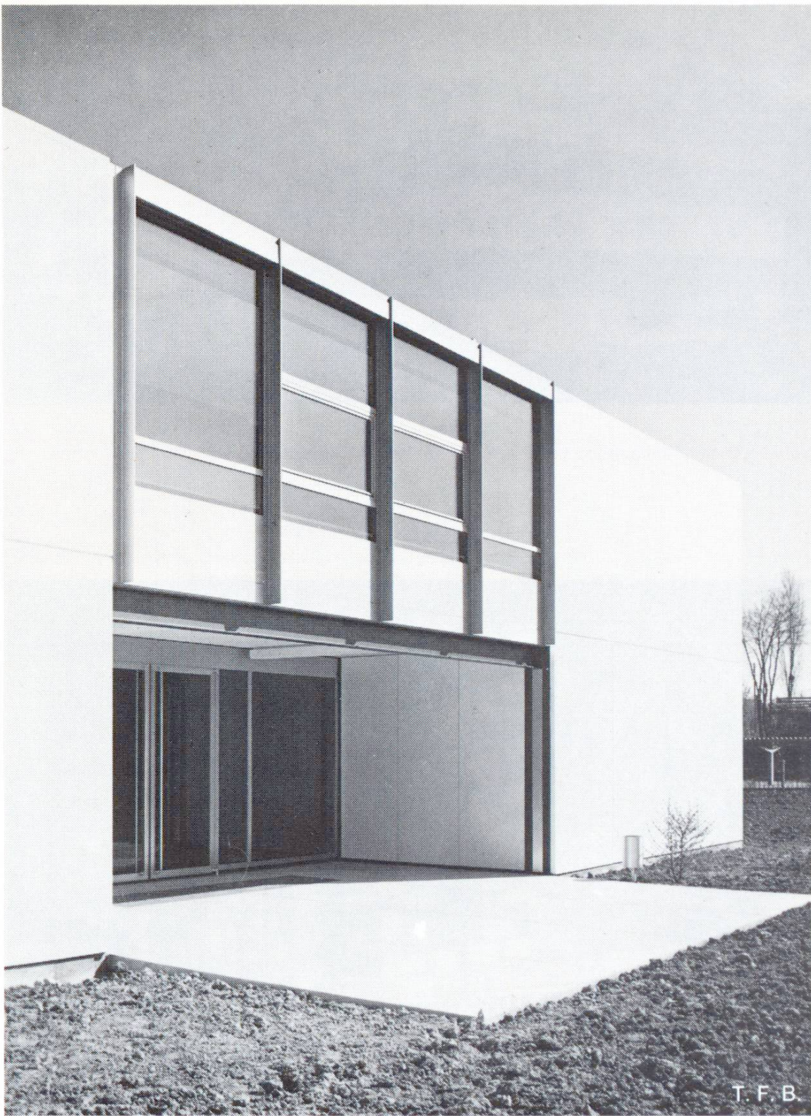
Abb. 5 Schulhaus in Hubersdorf. Glatte Betonschalung, gestrichen.
