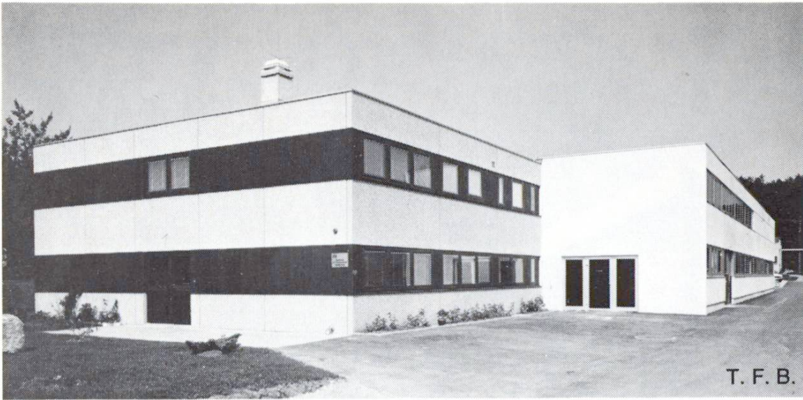
Abb. 6 Geschäftshaus in Le Mont. Waschbeton mit hellem Zuschlagsstoff.
