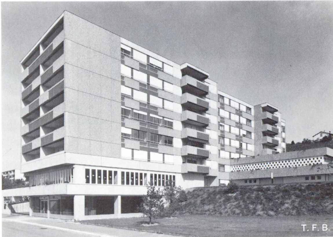
Abb. 7 Wohnbau in Lutry. Waschbeton mit dunklem Zuschlagsstoff, kombiniert mit Platten aus Holzschalung.
