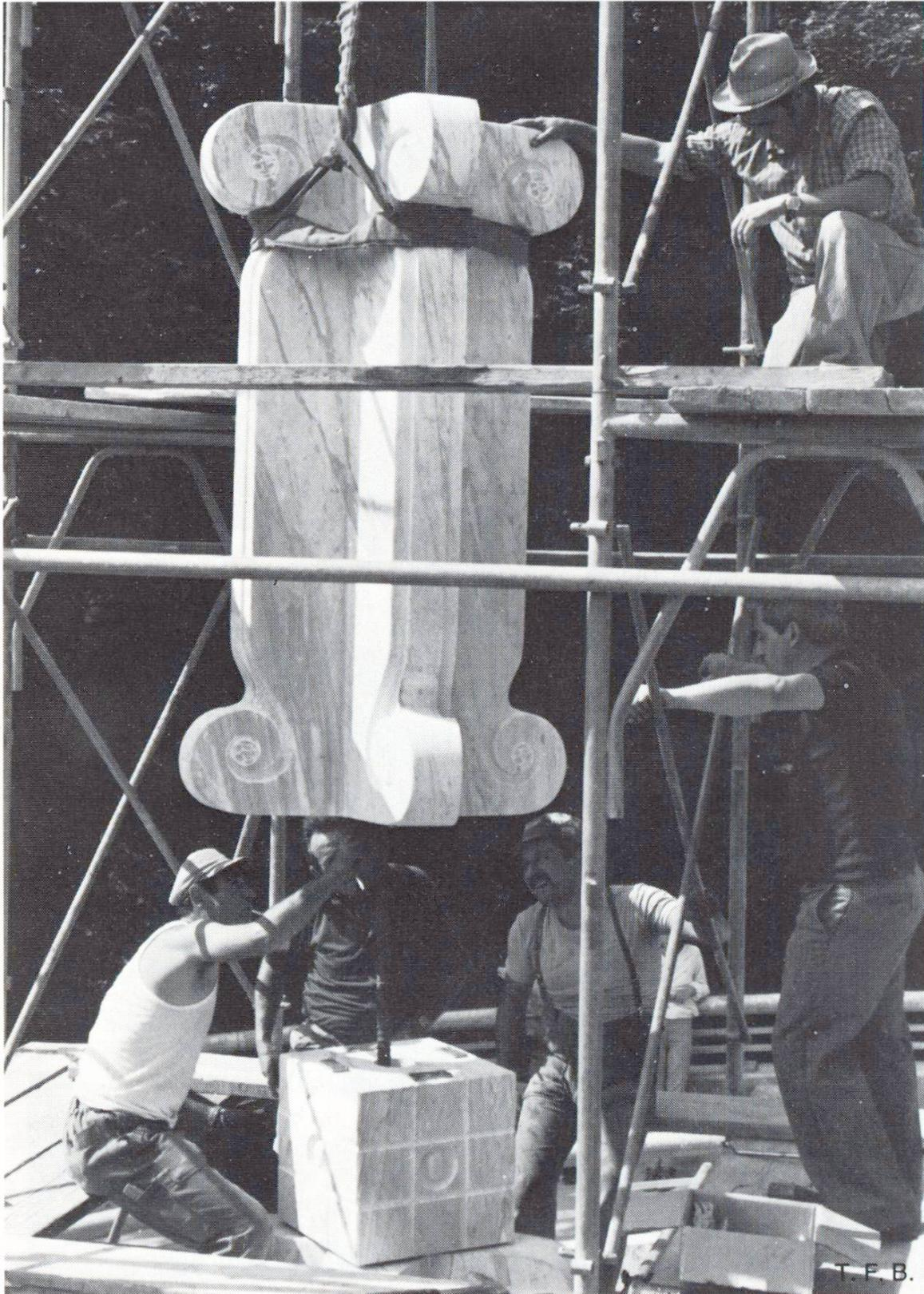
Abb. 4 Montage eines Elementes der Marmorplastik.
