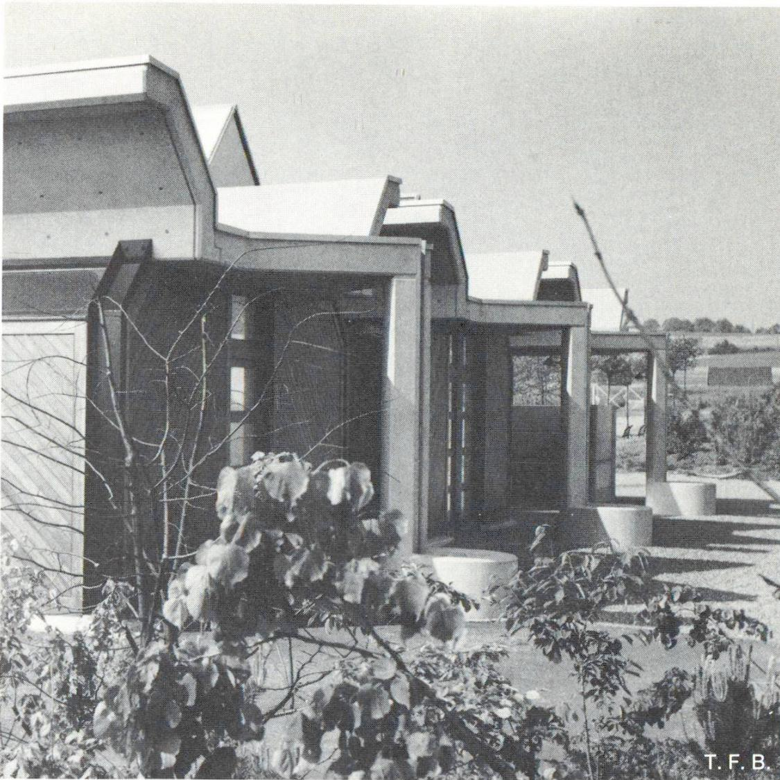
Funktion entsprechend durch die Ausgestaltung hierarchisch differenziert. Nach aussen bildet das grosszügig wirkende Betonskelett das ordnende Element. Dieses wird ausgefacht mit geschlossenen Holzwänden in Diagonalschalung. Fenster gibt es nur in Form von nicht einblickbaren Oberlichtern; das Innere wird nur da, wo Eingänge sind, vermittelt.
