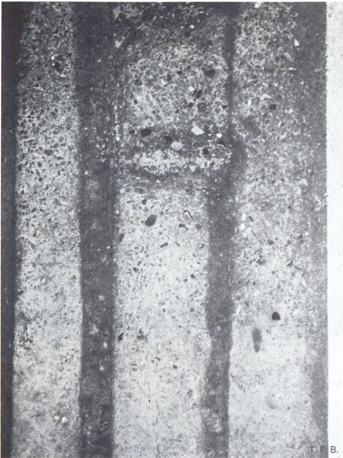
Abb. 10 Geschliffener Beton mit Entmischungsschäden infolge undichter Schalung.
