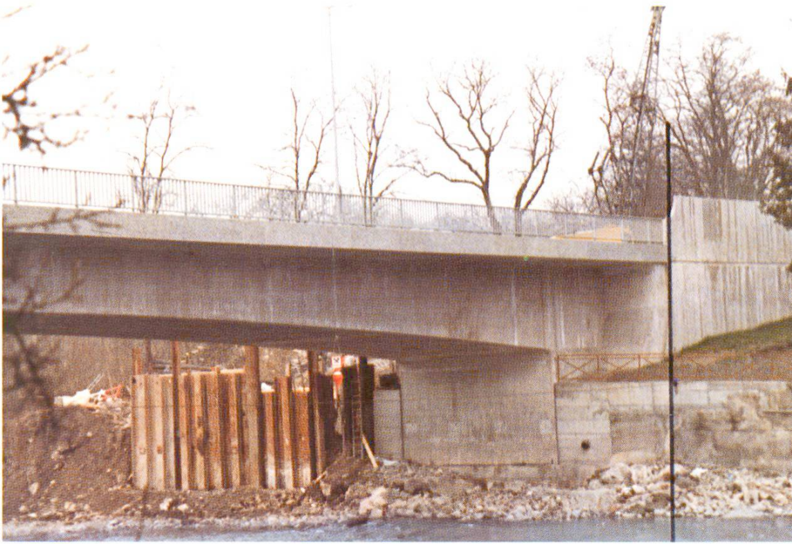
Abb. 4 Neubau Pont de Sierne I, Genf. Für die Brücke wurde Roche-Zement und für den Brückenkopf Eclépens-Zement verwendet (s. eingezeichneter Trennstrich). Es sind keine farblichen Unterschiede festzustellen.
