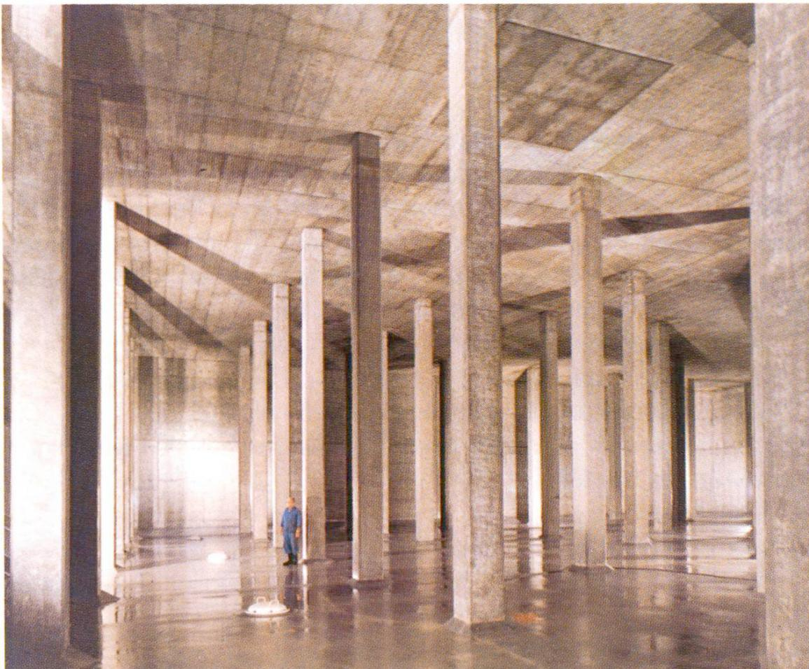
Trinkwasserreservoir in wasserdichtem Sichtbeton
