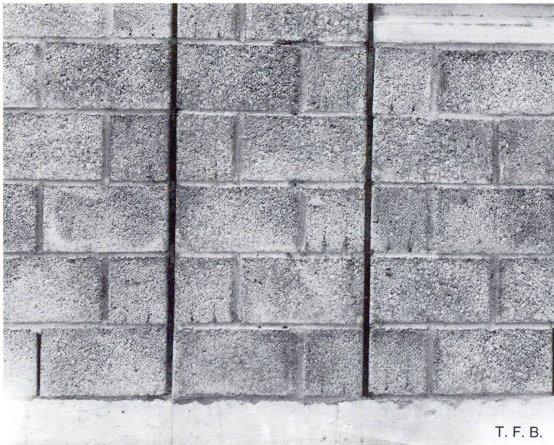
Abb. 10 Beton-Sichtmauerwerk mit einer verdünnten Dispersion gestrichen.
