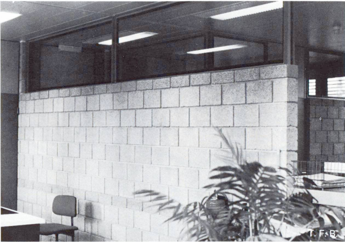
Abb. 14 Exakte Aufmauerung kombiniert mit Stahl-Fensterrahmen.
