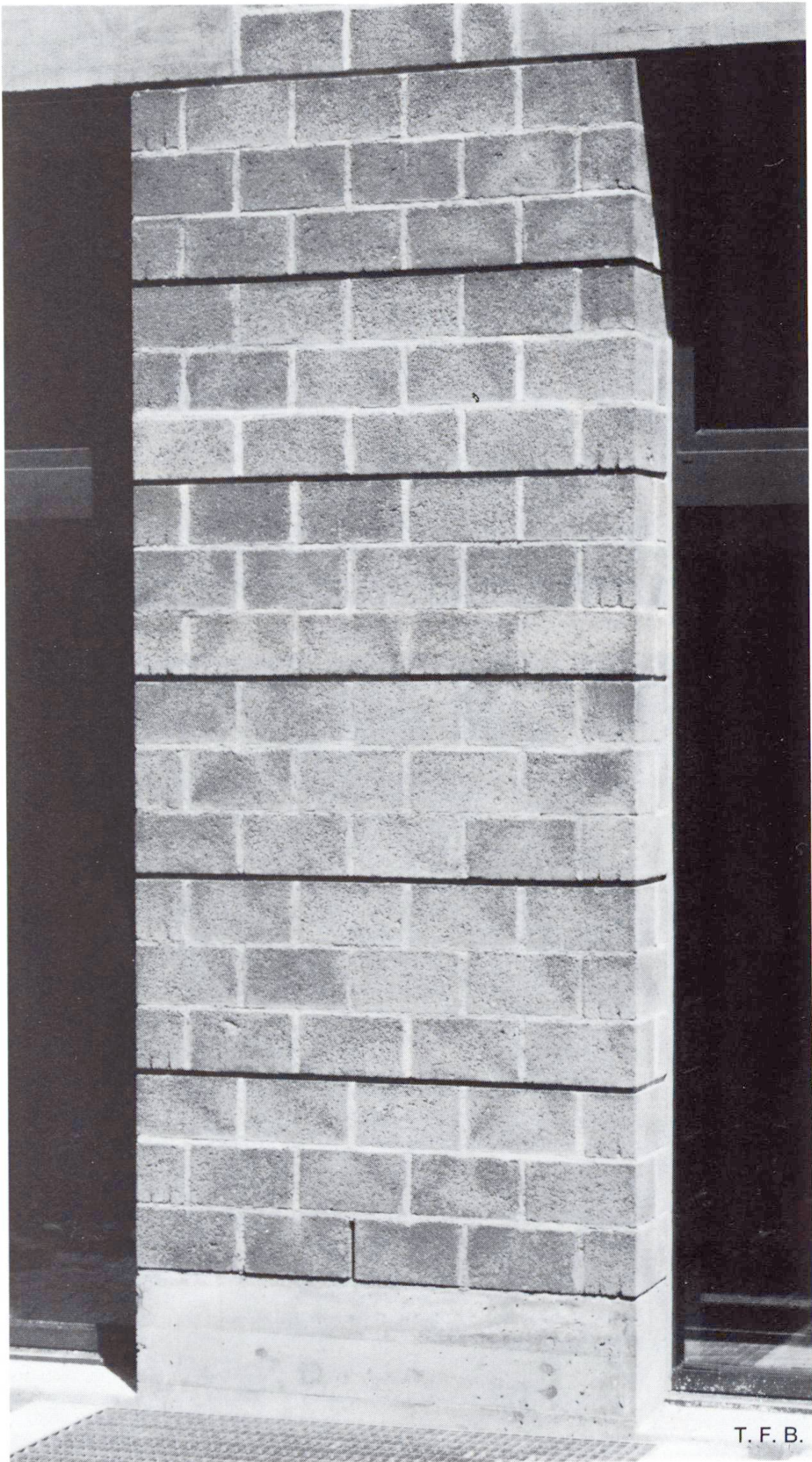
Abb. 8 Sichtmauerwerk in einem speziellen Verband.
