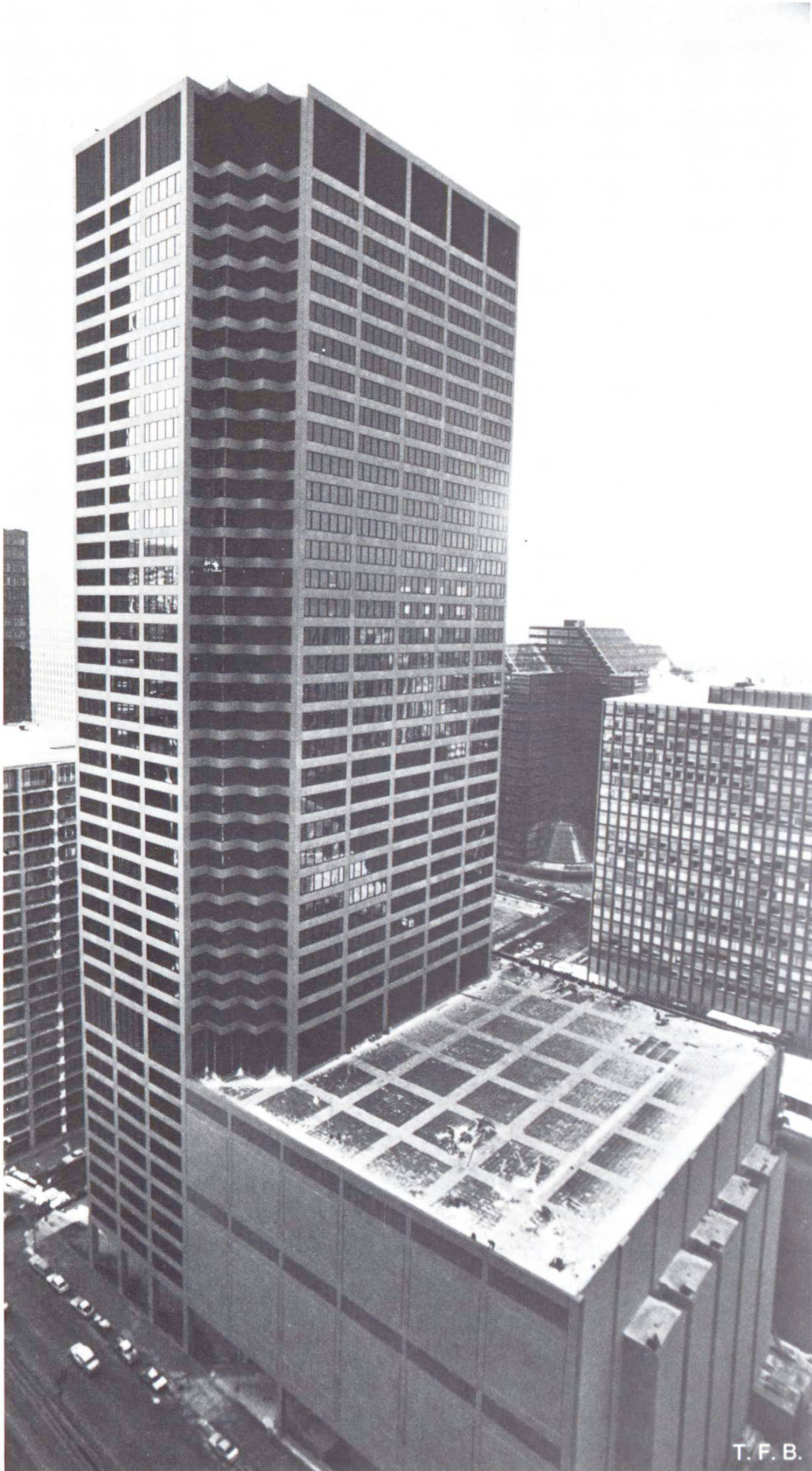
Abb. 10 Bauwerk nach Fertigstellung der 1. Bauphase, Dezember 1983.
