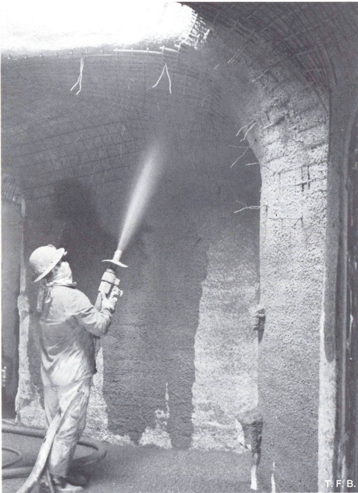
Abb. 5 Auftrag der zweiten Spritzbetonschicht.
