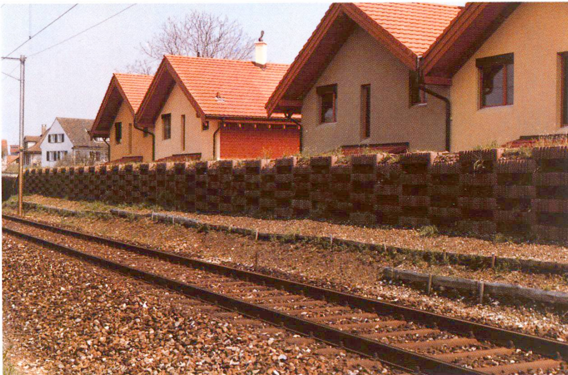
Abb. 4 Freistehende Lärmschutzwand zwischen Häuserreihe und Bahnlinie. Typ S aus Elementen von 100 \times 20 \times 60 cm und 160 kg Gewicht.
