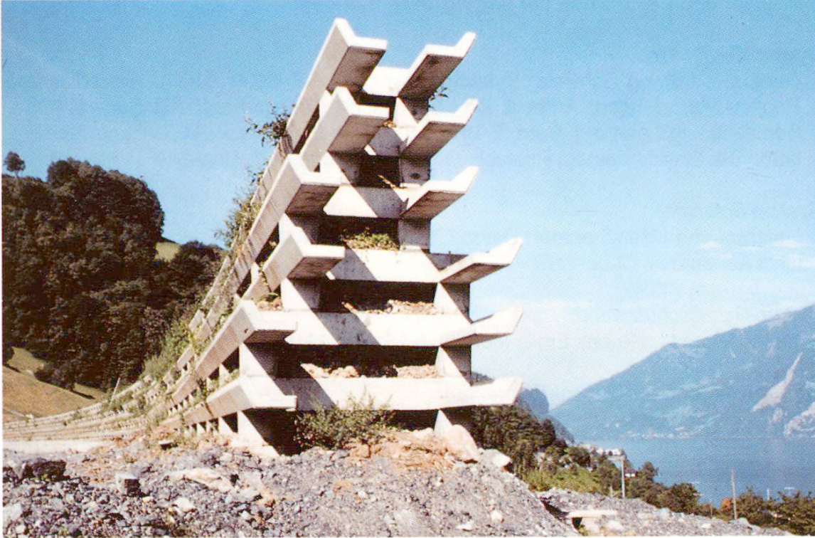
Abb. 1 Freistehende Lärmschutzwand (Baustelle N3 bei Mühlehorn, im Bau).
