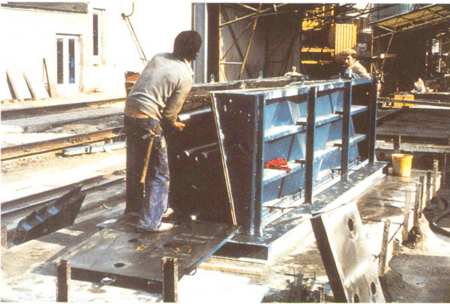
Stahlschalung für Säule Typ B. Vorfabrikation: Prelco SA, Genf. 5
