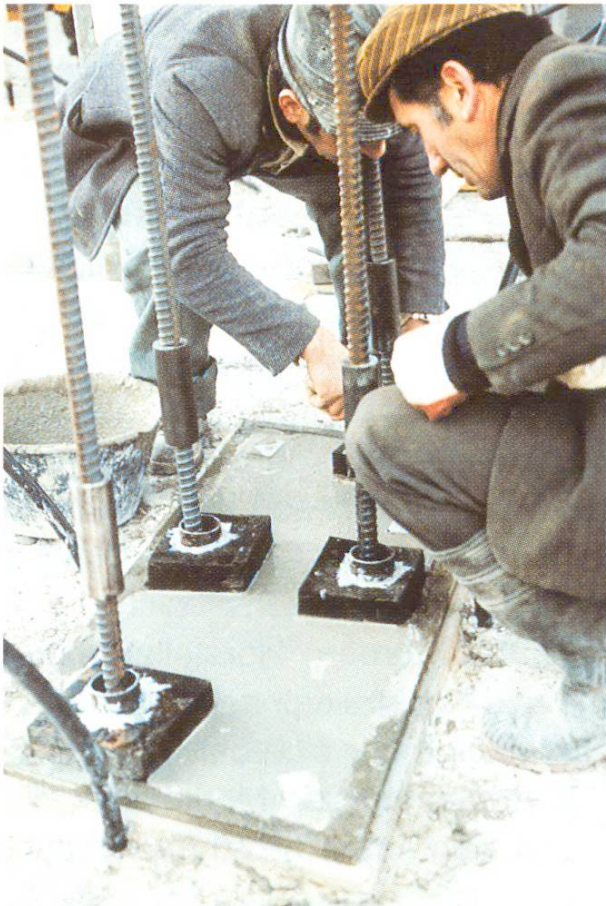
Verankerung der Säulen am Boden. Vorspannung: Spann-Stahl AG, Hinwil.
