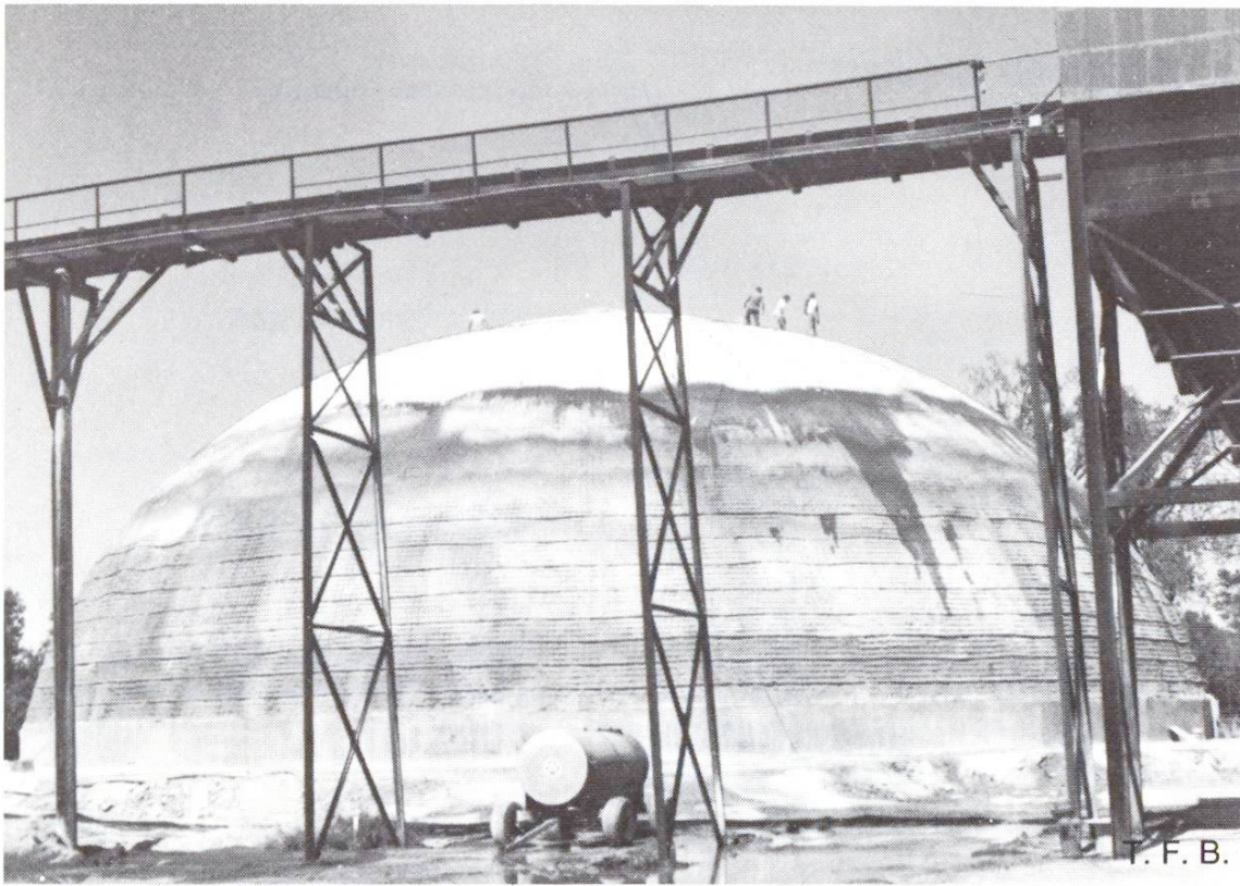
Abb. 7 Rundhalle ( \varnothing = 37,8 m, h = 15,3 m) während der Spritzbetonarbeiten. Aufbringen der ersten Schicht. Die Tragluftschalung ist begehrbar.
