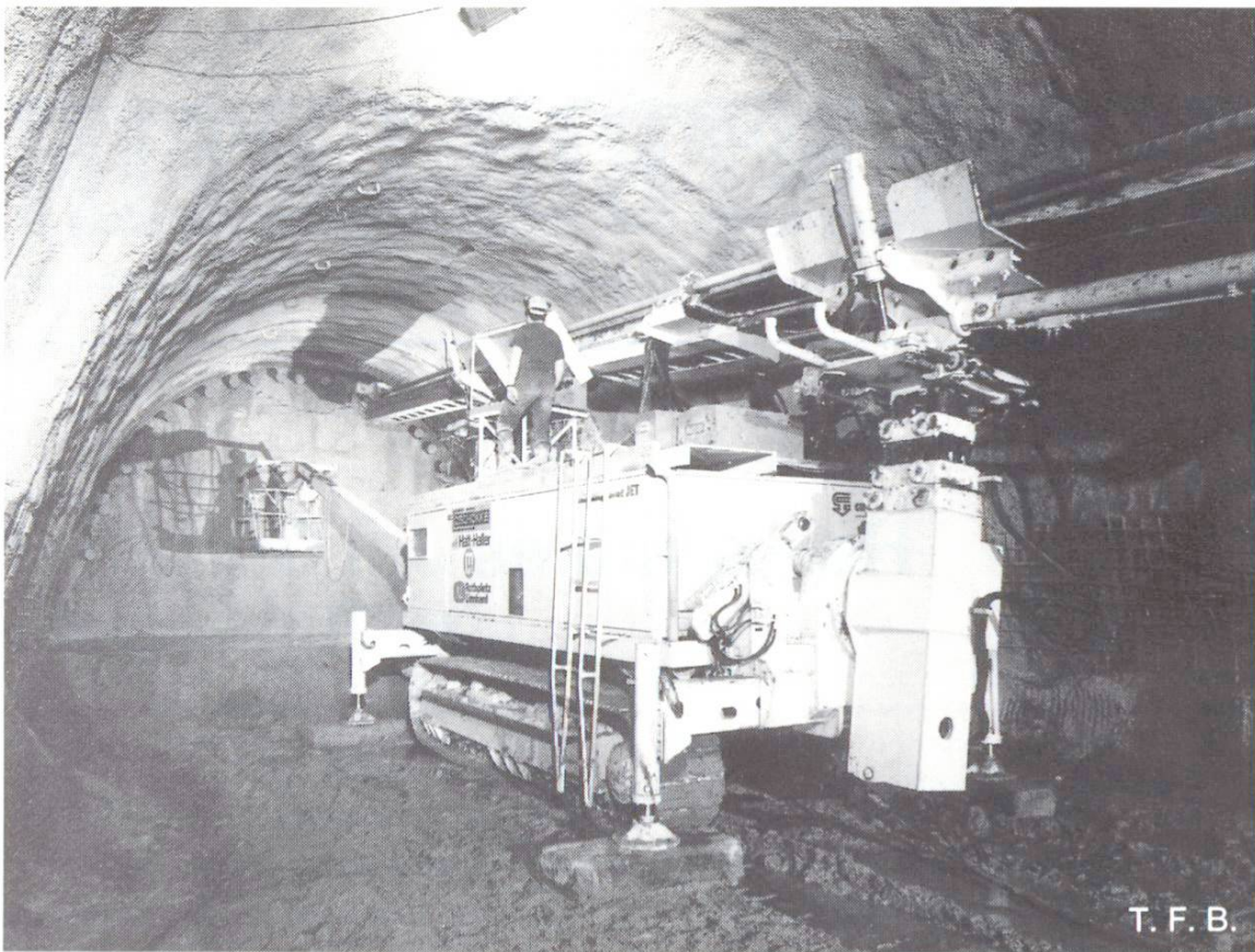
Abb. 1 Kalottenvortrieb im Lockergestein. Installation der Bohrmaschine für das Jet Grouting.
