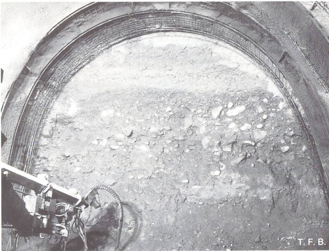
Abb. 6 Ortsbrust im Lockergestein, durch Schutzschirm gesichert. Einbau des Aussengewölbes in Etappen von 1 m.
