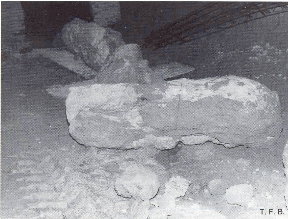
Abb. 9 Teil einer Jet-Säule. Zur Überprüfung der Materialeigenschaften wurde in der Ortsbrust eine Probesäule hergestellt und dann ausgegraben.
