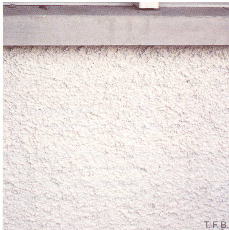
Abb. 14 Kellenwurf als Deckputz (Lindenplatz Pfungen).
