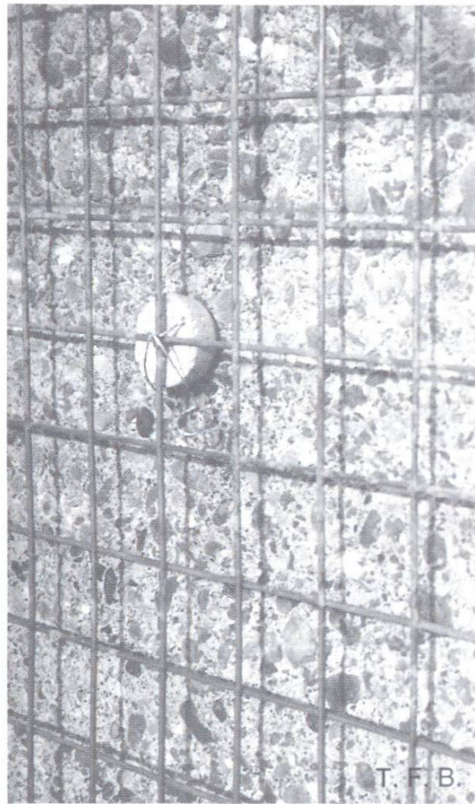
Abb. 7 Netzarmerung des Vorbetons, am bestehenden Beton gesichert.
